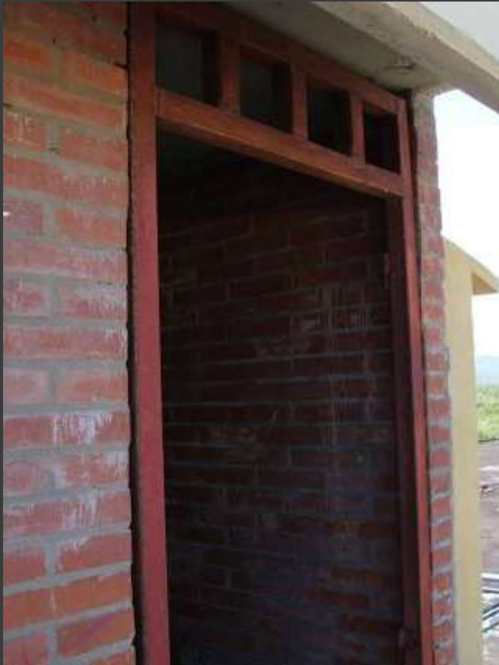
Entrada Azotea Edif. De Administracion.
